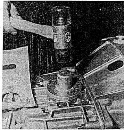
Mise en place du joint d'étanchéité de sortie de boîte.
